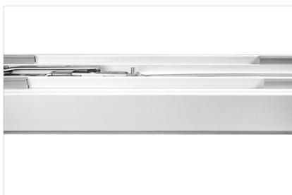
Entnahme der Dichtung bei einem Holzfenster
