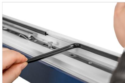
Entnahme der Flügeldichtung
